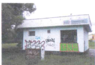
Budova č. s. 8395 - celkový pohľad JZ
