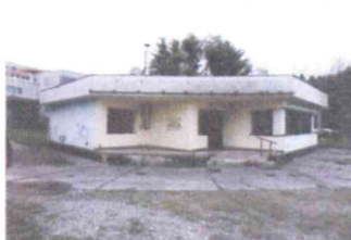
Budova č. s. 8395 - celkový pohľad JV
