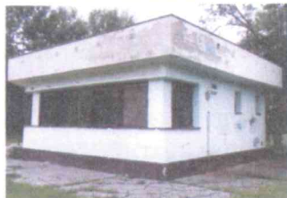
Budova č. s. 8395 - celkový pohľad SV
