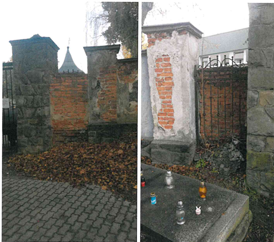
Fotodokumentácia súčasného stavu
