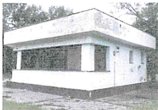
Budova č. s. 8395 - celkový pohľad SV
