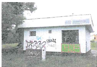
Budova č. s. 8395 - celkový pohľad JZ
