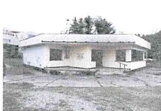
Budova č. s. 8395 - celkový pohľad JV
