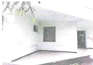
Budova č. s. 8395 - celkový pohľad SZ
