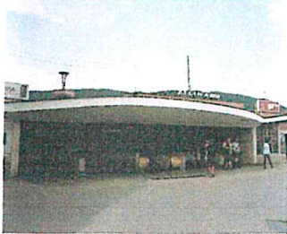
Celkový pohľad na vstupný portál do podchodu pod cestnou komunikáciou z Národnej ul.
