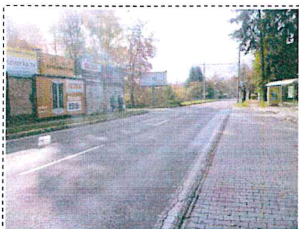
Prístup. kom.- Tajovského ul., smer JZ
