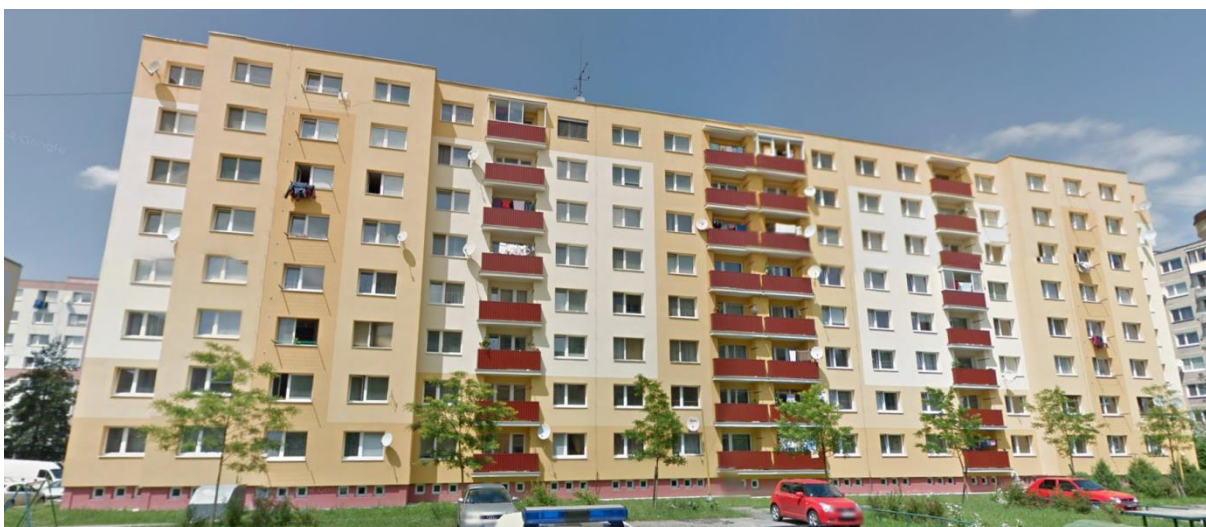
Obr. 79 Riešený bytový dom ul. Polomská 1781
