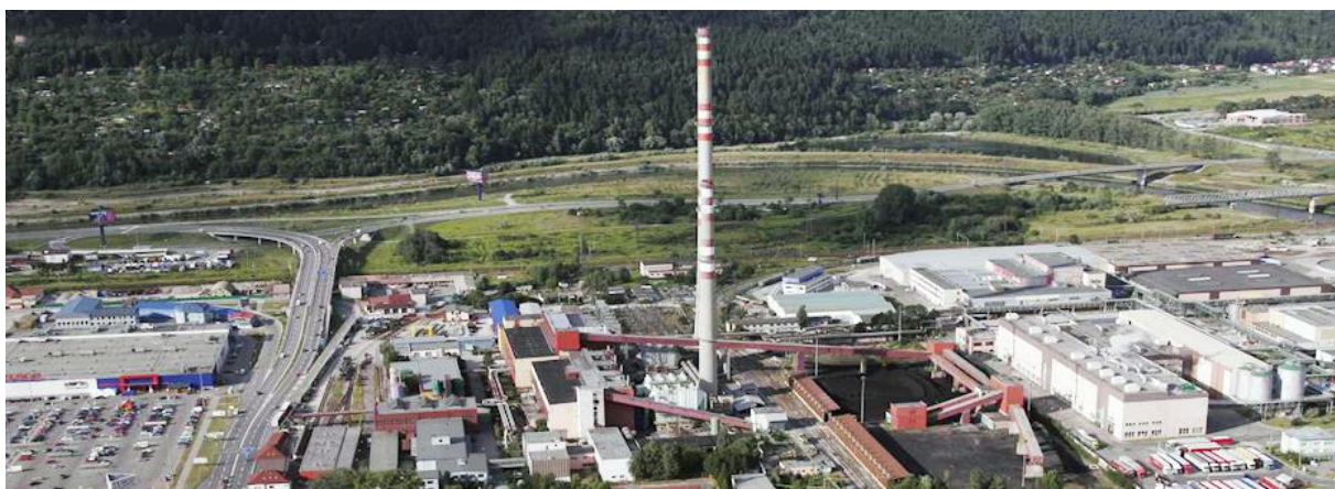
Obr. 10 Ťilinská teplárenská, a.s., Ťilina
