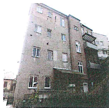
Bytový dom č. s. 1337 – celkový pohľad SV zadný z dvora – p. č. 2109/6
