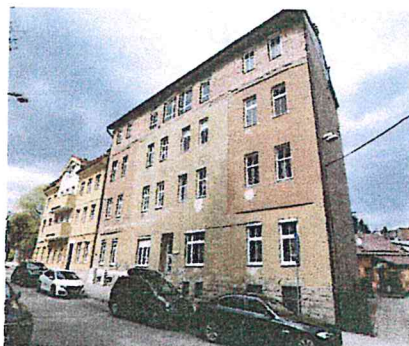
Bytový dom č. s. 1337 – celkový pohľad Z JV z Predmestskej ul.
