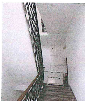
Spoločné priestory – hlavné schodište v dome
