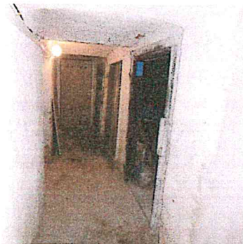
Spoločné priestory – komunikačná chodba v I. PP, vpravo vstup do Priestoru č. 1
