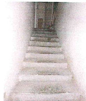
Spoločné priestory – schodište do I. PP
