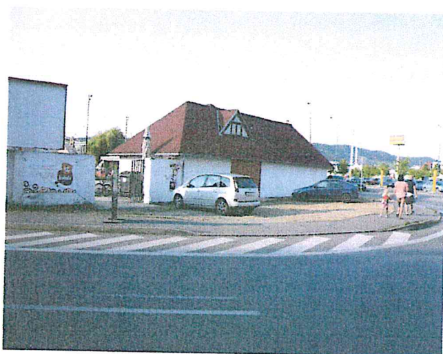
Celkový pohľad SSV na priestor situovania hodnoteného pozemku - p. č. 9055 z ul. Za plavárňou
