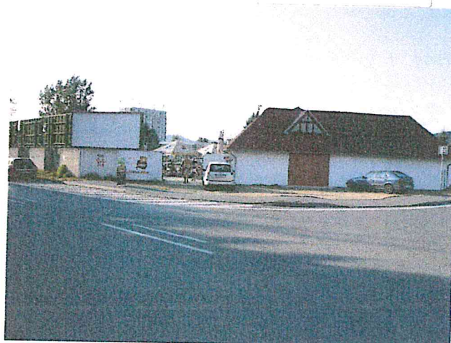
Celkový pohľad SSZ na priestor situovania hodnoteného pozemku - p. č. 9055 z ul. Za plavárňou
