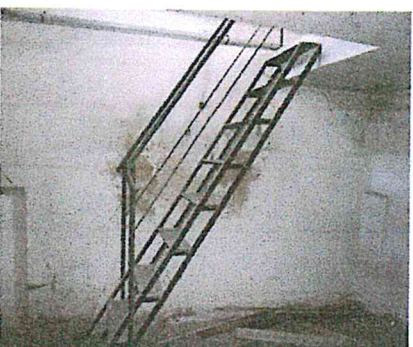
Budova bez súp. č. na p. č. 5396/8 - dispečing SAD - podzemné podlažie
