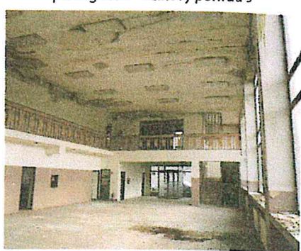
Budova bez súp. č. na p. č. 5396/8 - dispečing SAD - centrálna hala prízemja
