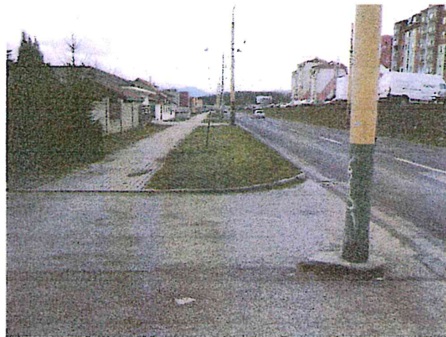
Detailný pohľad S na spevnenú plochu - prechod z komunikácie cez pôvodný zelený pás a chodník ( časť za stožiarom osvetlenia )
