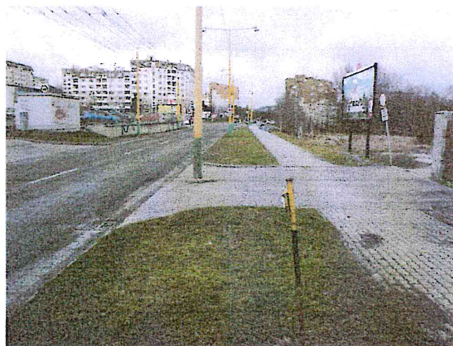
Detailný pohľad J na spevnenú plochu - prechod z komunikácie cez pôvodný zelený pás a chodník ( časť pred stožiarom osvetlenia )
