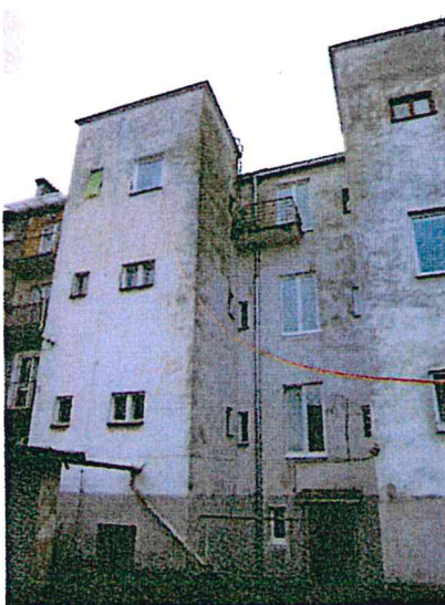
Pohľad z dvora
