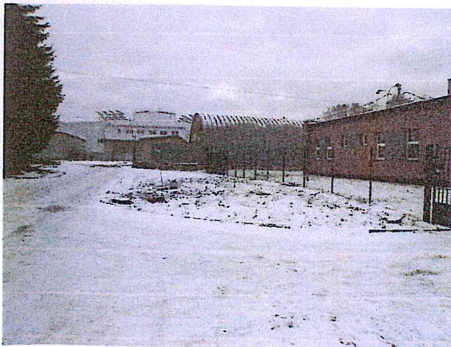
Prístupová vnútroareálová komunikácia - vpravo areál fy Mairon, s. r. o.
