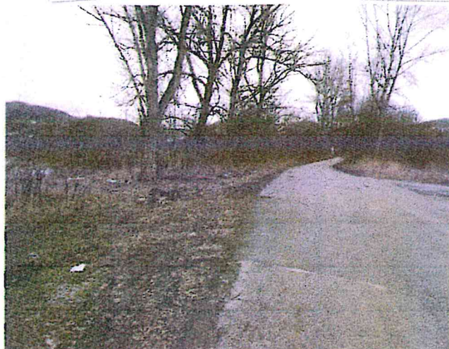
Pohľad JZ na obslužnú komunikáciu za priemyselnou zónou, ktorou prechádza kanalizačné potrubie do výpustného objektu na ľavom brehu Váhu
